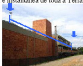
Fig. 2 - Receptores espaçados em 100 m na direção leste-oeste magnética no Prédio Sede do Centro Regional Sul de Pesquisas Espaciais CRSPE/INPE – MCT, em Santa Maria, RS.
