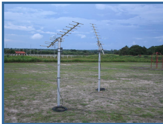
FIGURA 7.1 - Antenas do tipo Yagi do Sistema VHF, instaladas no Observatório Espacial de São Luís – OESLZ/INPE – MCT, São Luís-MA.
